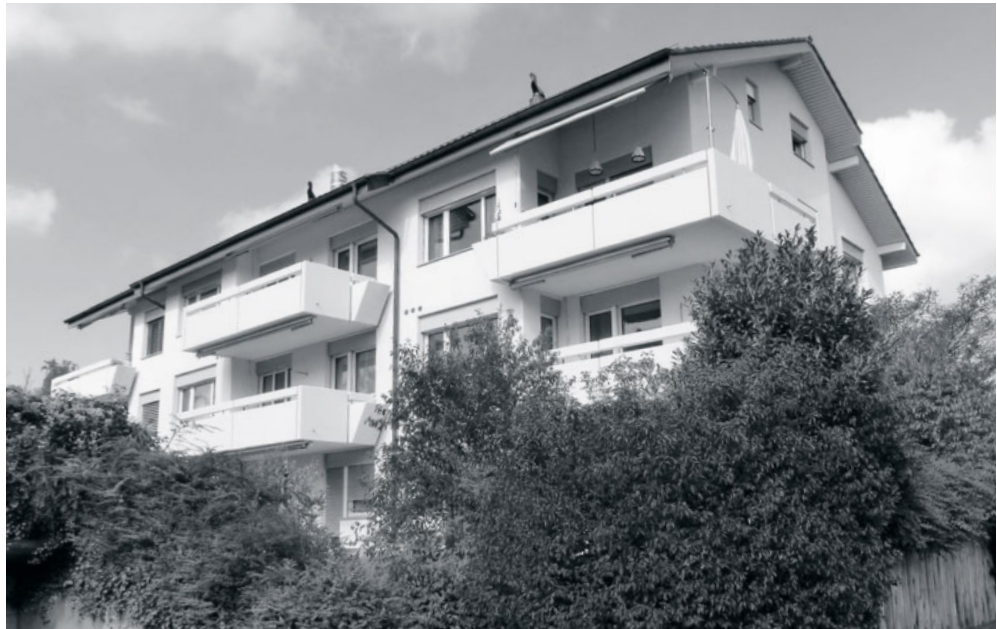
Sanierungsprojekt in Rudolfstetten AG, Hofackerstrasse 44–48
